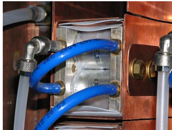
Detail montáže kondenzátorů
